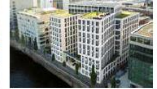
Speicherstraße 55 Frankfurt am Main
